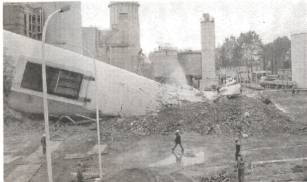
Un momento del parziale smantellamento della centrale di Ostiglia
